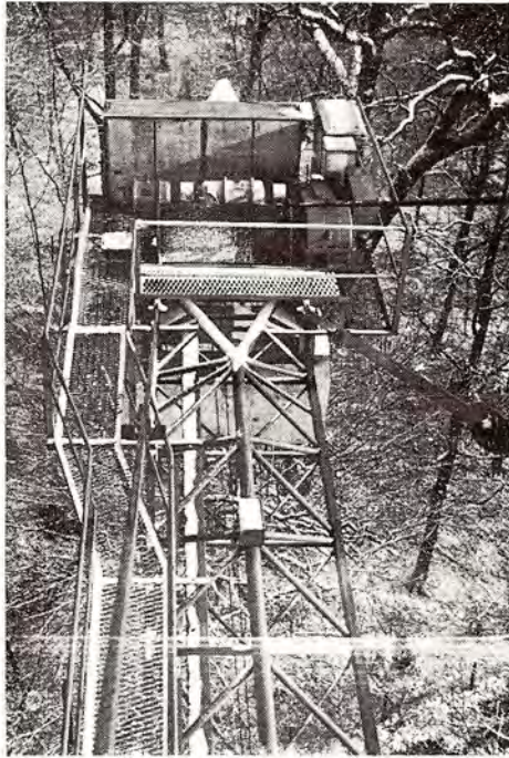
Bild 1: Hubwinde auf Gegenausleger.
