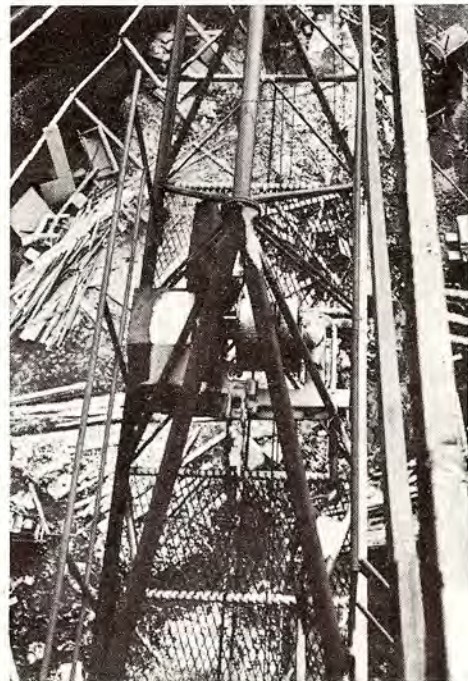
Bild 2: Traversierwinde auf dem Ausleger.
