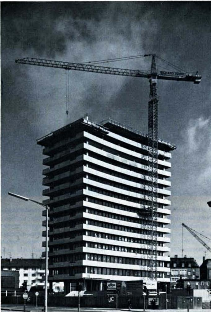
Abb. 4: Charakteristischer stationärer Einsatz eines Katzausleger-Kletter-Kranes mit Verankerung.
