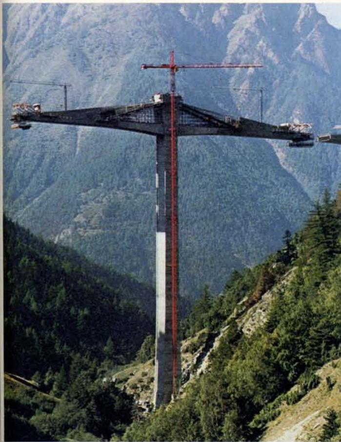
und einer Hubgeschwindigkeit von 130 Meter pro Minute bis 1,4 Tonnen eingebaut. Eine zusätzliche Schwenkbremse mit Fussbetätigung diente der Sicherheit im Falle eines Stromausfalls. Für das Kletterwerk wählte man eine verstärkte Konstruktion, welche das Klettern bis zu einer Windgeschwindigkeit von 40 Kilometer in der Stunde erlaubte.
