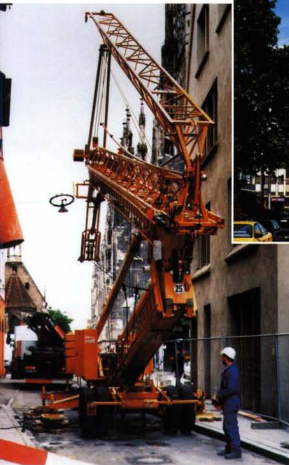
Gelenkig: Statt über eine komplizierte Seileinsicherung wurde der 20 SE mit Hydraulikzylindern aufgerichtet. Der Aufstellvorgang wurde dadurch noch einfacher.
