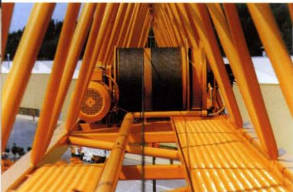
◀ Flach gequetscht: Für die Diagonalen der Ausleger wurden die Stahlrohre am Anschluß flach gequetscht und dicht verschweißt.
