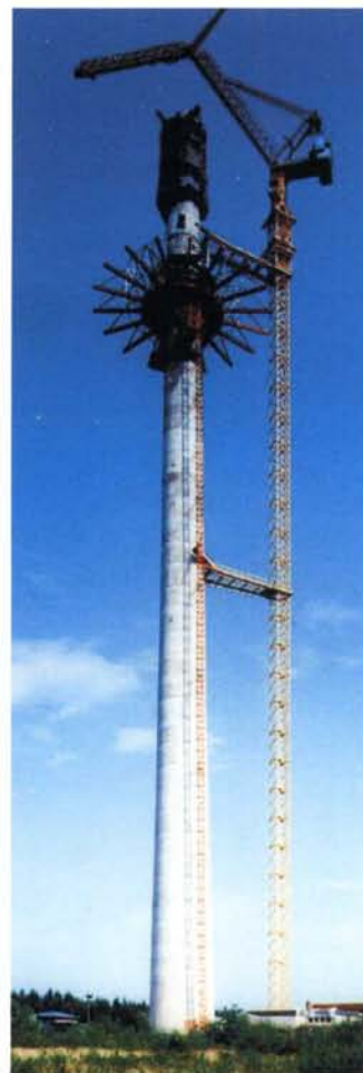
▲ Geknickt: Speziell für Bauwerke, die nach oben hin immer schlanker werden, wie Kühl- oder Fernmeldetürme, wurden die Krane mit dem charakteristischen Knickausleger für große Reichhöhen entwickelt.
