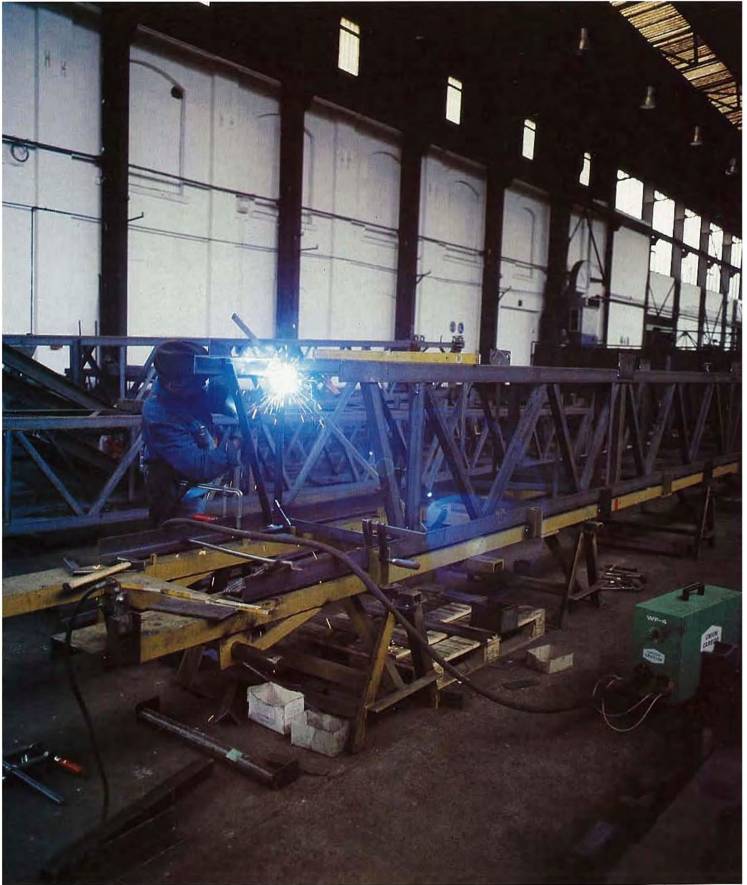
Zusammenbau einer Turmkonstruktion in der Schweißvorrichtung
