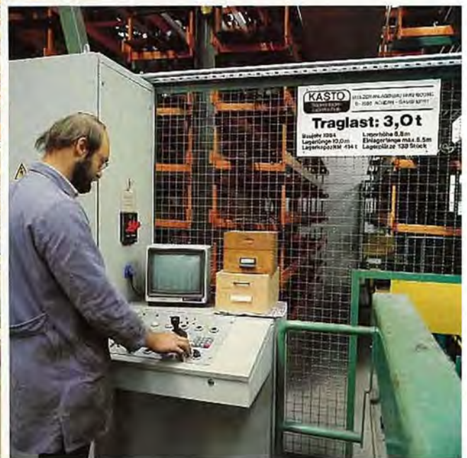
Schaltpult und Bildschirm des Computer-gesteuerten Hochregallagers
