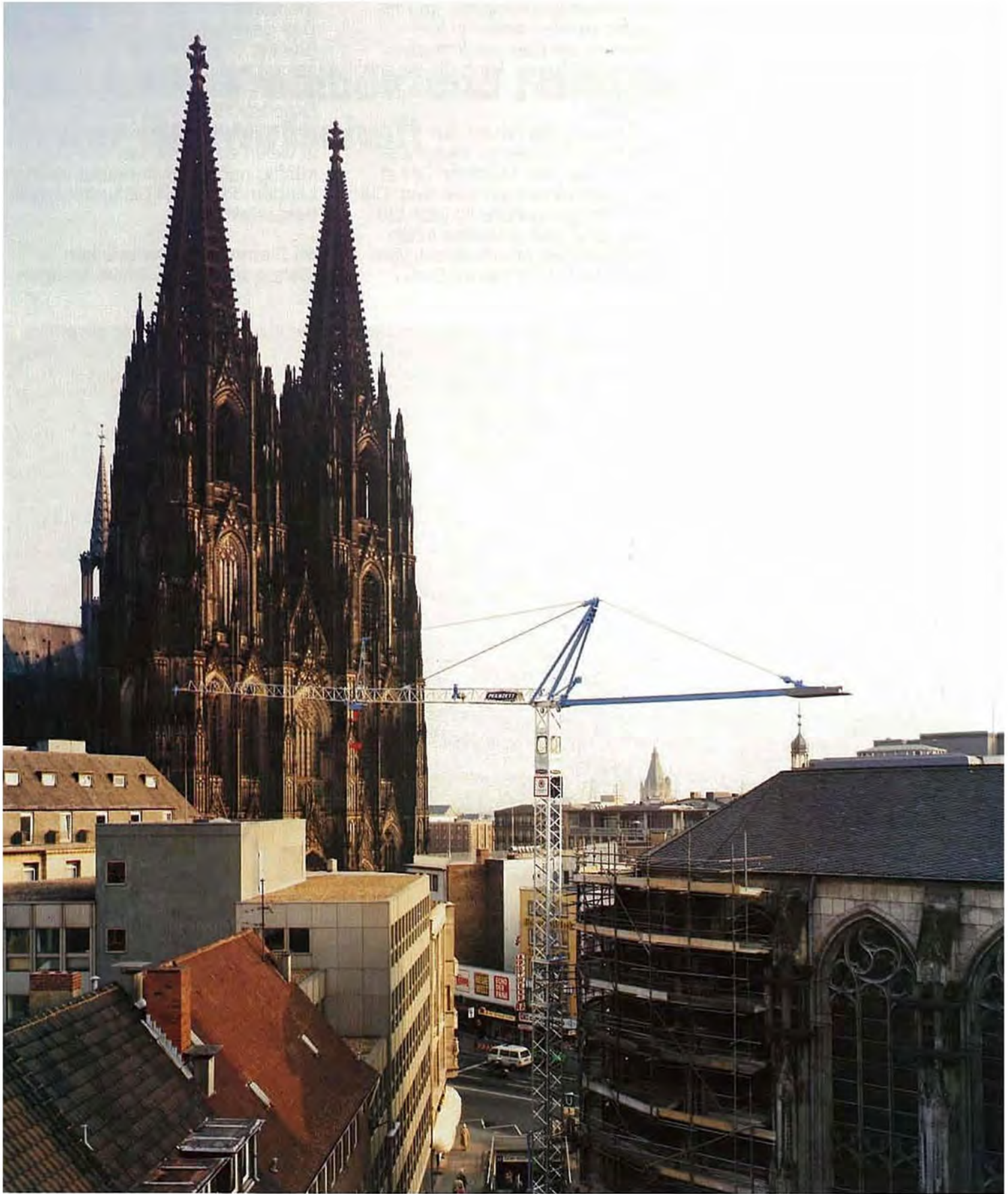
CK 3512 - City - Schnellmontagekran an der Baustelle St. Andreas Kloster in Köln
