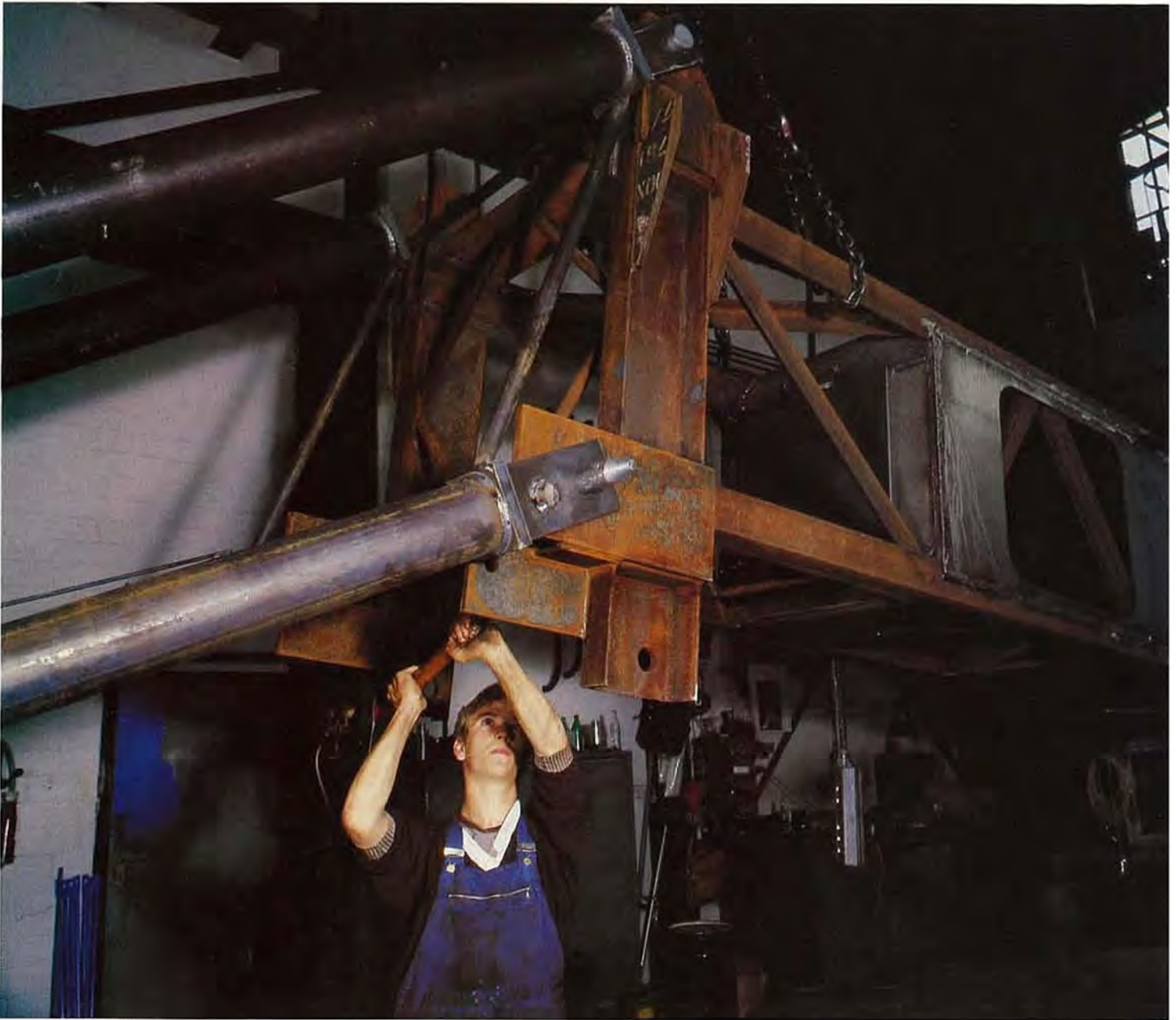
Vormontage einer Turmkonstruktion vor dem Feuerverzinken
