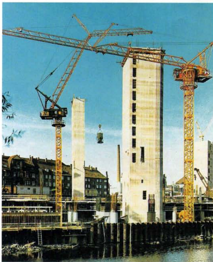
Oben: Weitz-G-280-Grossturm- drehkran mit maximal 20 t Tragkraft. Ab 1964 wurden in der Schweiz solche Giganten eingesetzt. (Foto P. Meyer)
